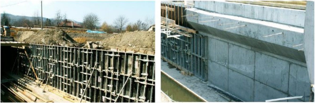
Szalunki Midi Box na budowie węzła i przyczółka drogi S69 Bielsko-Biala - Żywiec
