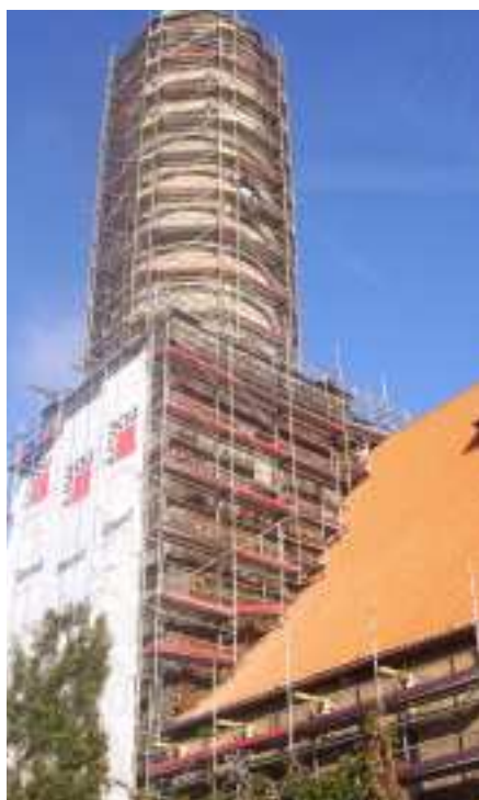
Fot. 1 Rusztowanie wiszące – Ratusz Lwówek Śląski
