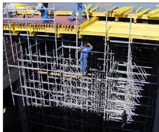
Fot. 2 | Szalunki stropowe wsparte na wieżach zbudowanych z rusztowań ROTAX
