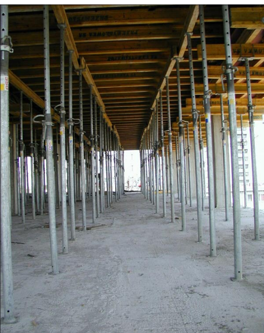
Fot. 1 | Szalunki stropowe wsparte na podporach
