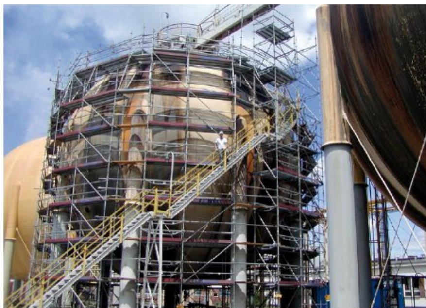
Rusztowania Rotax Plus mają zastosowanie przy obiektach przemysłowych z dużą liczbą instalacji i rurociągów
