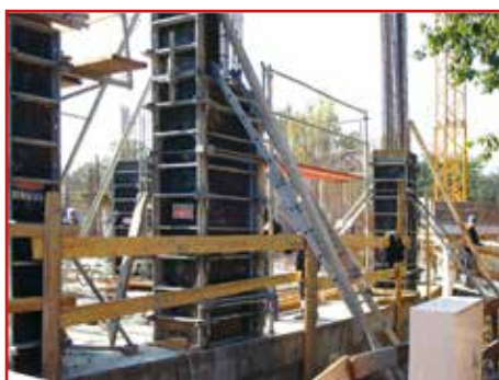
Формирование колонн - щиты MIDI BOX и опалубочные замки
